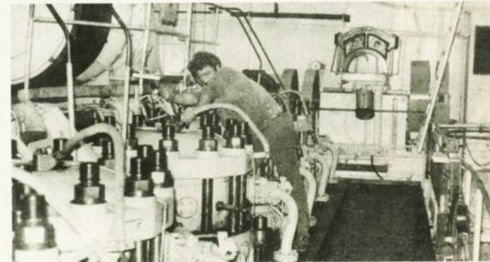
Blick in den Maschinenraum des MS „Altenburg“
