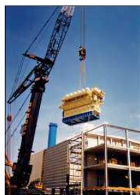
Einbau eines Diesel-Gasmotors auf ein Blockheizkraftwerk in Calbe.
