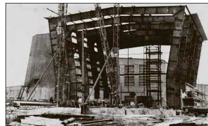
Bau einer Halle Anfang der 1960er Jahre, in der Motoren auf mehreren Prüständen montiert und erprobt werden.
