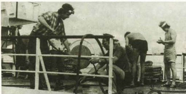
Rekonstruktion der Poop und vorbereitende Arbeiten zum Bau des Schwimmbades.
