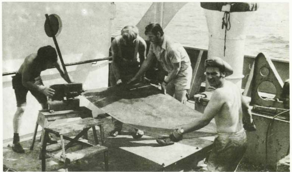
Genossen des MS „Werner Seelenbinder“ während eines Subbotniks auf der letzten Reise an Bord. Hier werden die Wände des Schwimmbades zugeschnitten.
