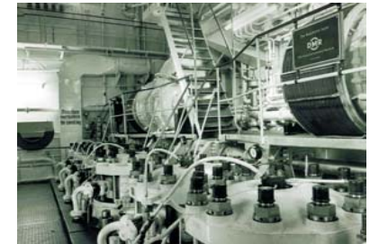
Die obere Zylinderstation der Hauptmaschine, MAN-Lizenzbau des Dieselmotorenwerkes Rostock.
